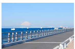
館山夕日栈橋("渚の駅"たてやま) (海のマルシェ, なぎさ食堂)
